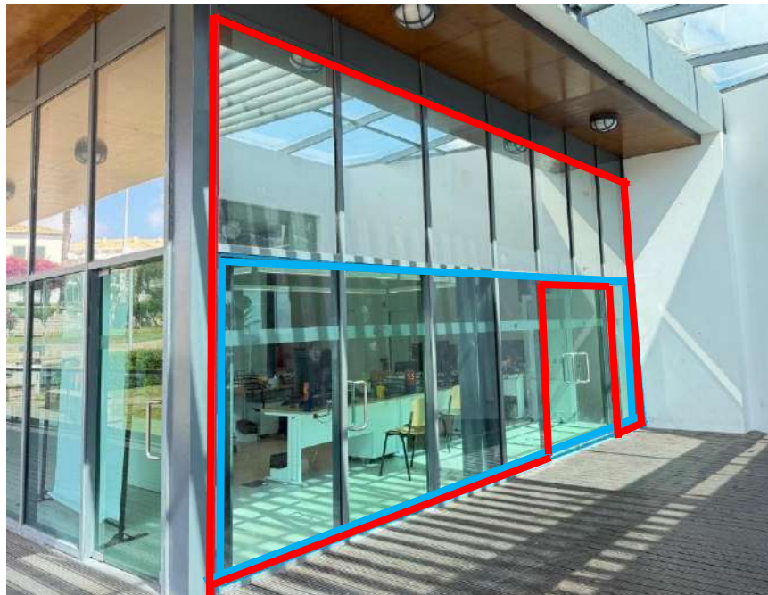
Figura 2 – Fachada lateral do edifício
