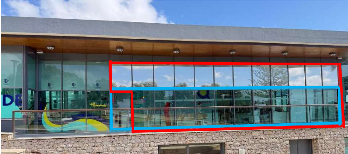
Figura 1 – Fachada principal do edifício
